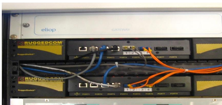
*Figura.1.12. Gateway de comunicación de la S/E Selva Alegre*
